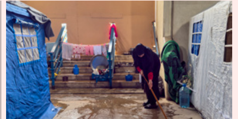
Når det regner kommer vannet inn gjennom de store publikumsinngangene, selv om det er satt opp presenninger mot regn og vind.
